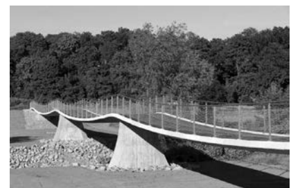
Foto: Ostansicht der Fußgänger- und Radwegbrücke,
