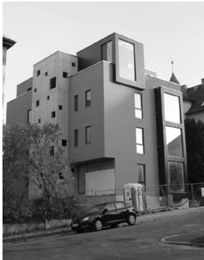
Fassade des Wohnhauses in Holzbauweise
