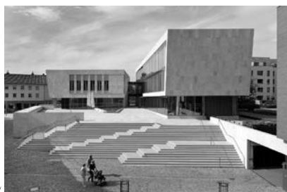
Ostansicht des Bürgerhauses mit Stadtbibliothek mit Terrasse und Wasserbecken
