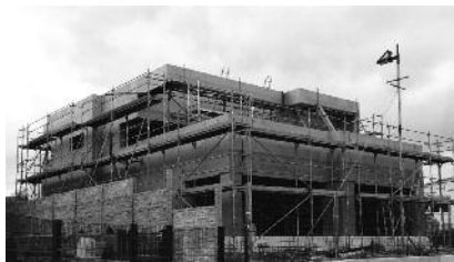
Bautenstand November 2013 (Foto: Bauherrschaft).
