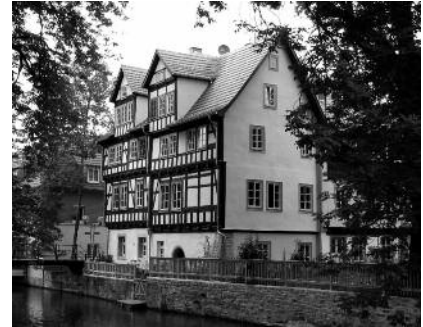
Ansicht Breitstrom nach der Sanierung.
