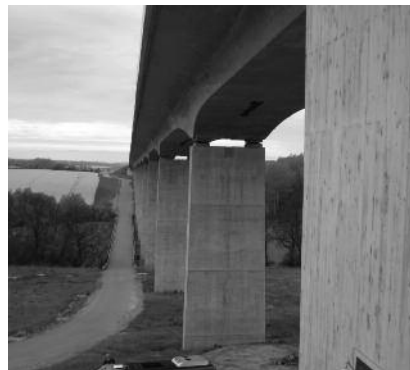
Scherkondetalbrücke: Seitenansicht der Konstruktion
