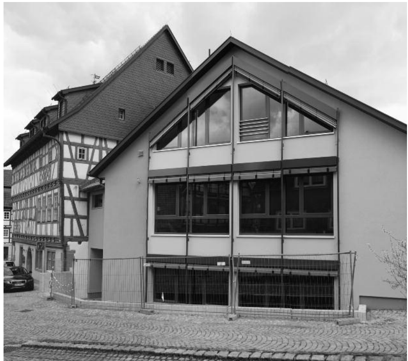
Der neue Anbau auf der Gebäuderückseite ist optimal in das Grundstück eingepasst und tritt in seiner Erscheinung hinter das historische Gebäude zurück.
