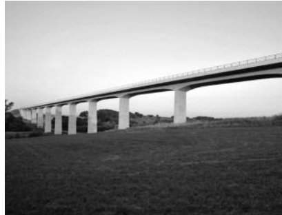
Eisenbahnbrücke Scherkondetal, Quelle: Brückenbaupreis 2012.
