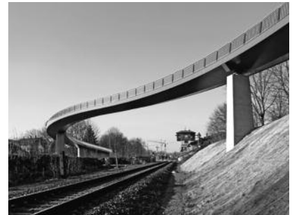
Blaue Welle Flöha, Quelle: Brückenbaupreis 2012.
