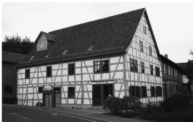
Stadtmühle Bad Blankenburg nach den Sanierungsarbeiten.
