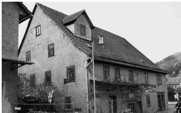
Stadtmühle Bad Blankenburg vor Beginn der Sanierungsarbeiten.
