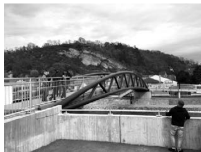
Fuß- und Radfahrbrücke in Camburg (Saale)
