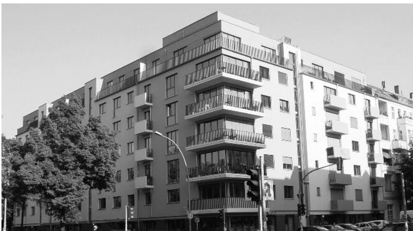
Grauwasserrecycling mit vorgeschalteter Wärmerückgewinnung. Passivhaus in Berlin-Prenzlauer Berg, Arnimplatz. In Betrieb seit 2012. Foto von K. W. König
