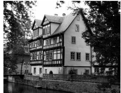
Ansicht Breitstrom nach der Sanierung.
