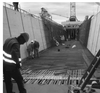
Bewehrungsarbeiten am Überbau und Blick zum Westportal Osterbergtunnel
