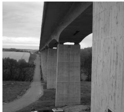
Scherkondetalbrücke: Seitenansicht der Konstruktion
