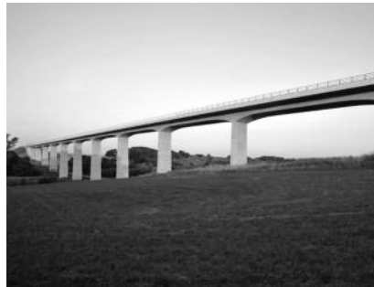
Eisenbahnbrücke Scherkondetal, Quelle: Brückenbaupreis 2012.
