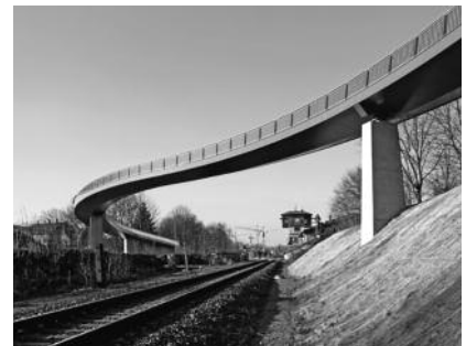
Blaue Welle Flöha, Quelle: Brückenbaupreis 2012.
